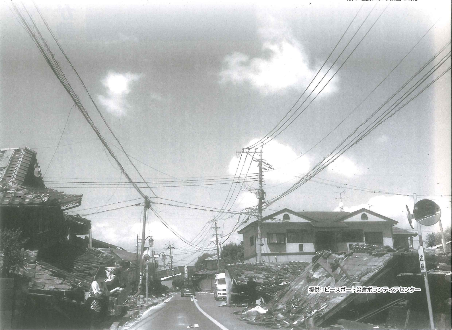
熊本地震による被害の様子
