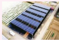
畑の上に太陽光パネルを設置した森のソーラー古河発電所(茨城県)
